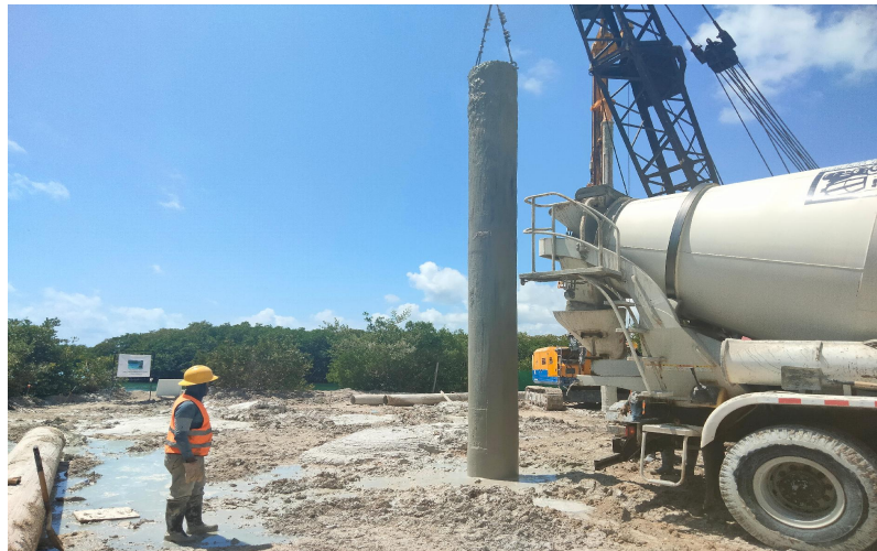
Ubicación: MUELLE PLAYA LINDA / T6 01 Actividad: colado de pilas de inclusión rígida
