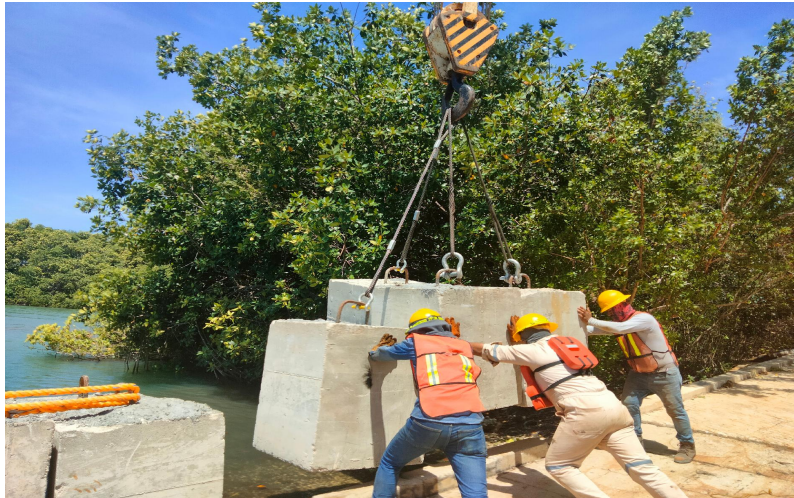
Ubicación: MUELLE TAJAMAR / T6 02 Actividad: proceso de lanzamiento de rampas y portazancos para barcazas
