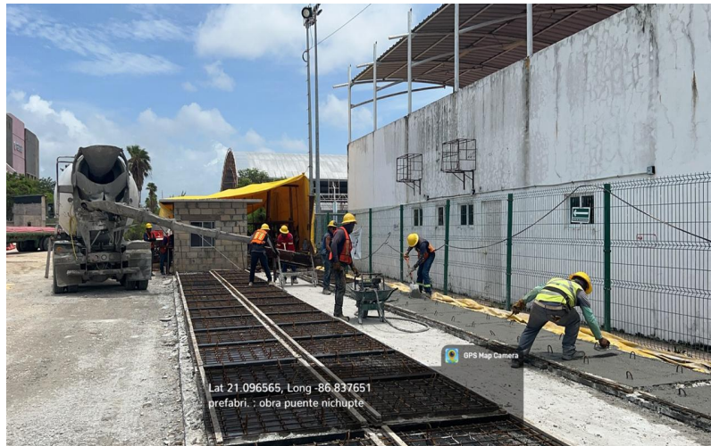
Ubicación: PLANTA DE PREFABRICADOS DE CONCRETO / T7 PP01 Actividad: colado Prelosas ( 81 pzas tipo T-1 ) concreto premezclado tiro directo Fc=300 kg/cm2.
