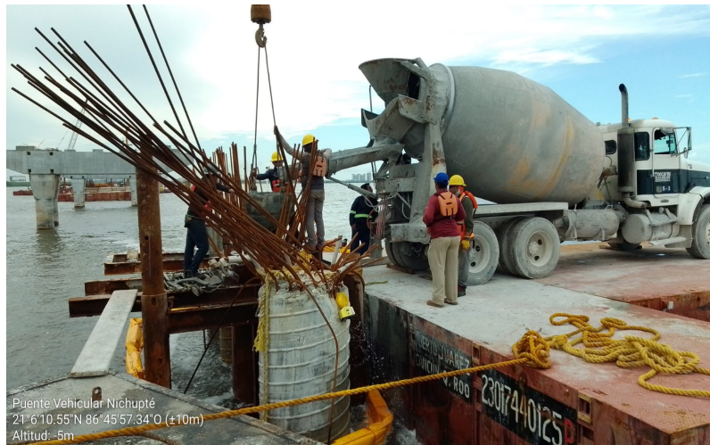
Ubicación: PILA B / T4 A115 POB Actividad: Descarga de concreto hidráulico para el colado de pila cimentación B adicional del apoyo 115.
