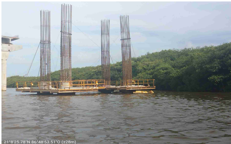
Ubicación: PILA Y COLUMNA 001 / T3 A60 P01 Actividad: Se inicia el armado de acero de refuerzo en columnas del apoyo 60, tramo 3 zona top down
