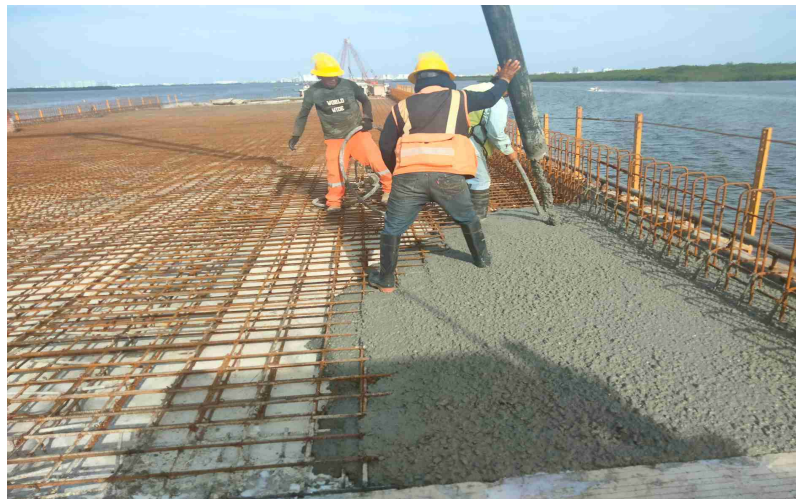
Ubicación: LOSAS DE CALZADA / T4 TAB074-075 LC Actividad: Inicia colado de losa de calzada claro 74.5-75.5, tramo 4 zona lagunar.
